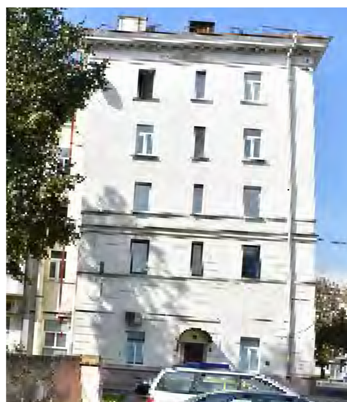
Фрагмент дворового фасада
